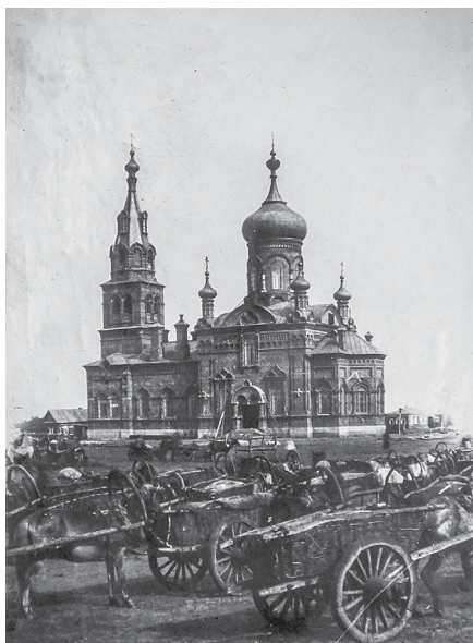
Фото 2. Вид храма после снятия строительных лесов
